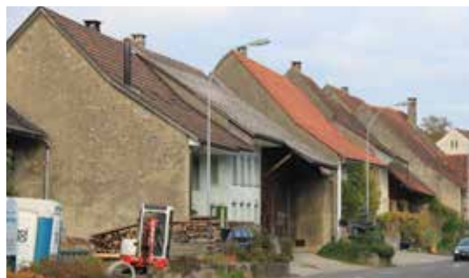
Der Strassenraum wird durch parallel stehende Firste betont
