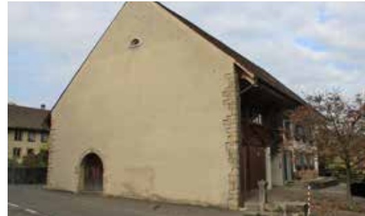
Brandmauer mit Lünettenfenster
