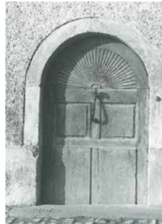
Fenster- und Türeinfassungen
