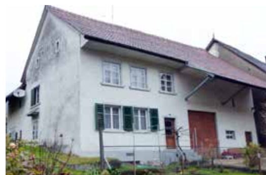
Typische Mehrzweckbauten (Einhausbauten), zweigeschossig mit Wohntrakt, Stall, Tenn und Remise
