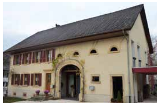
Beispiele gemauerter Mehrzweckgebäude
