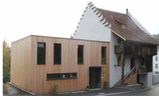
Nebenbau mit Flachdach
