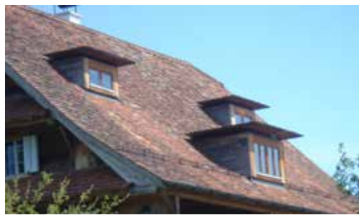
Orthogonale Schleppegauben
