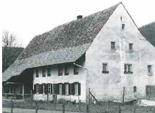
Lage der Fenster unter dem Vordach
