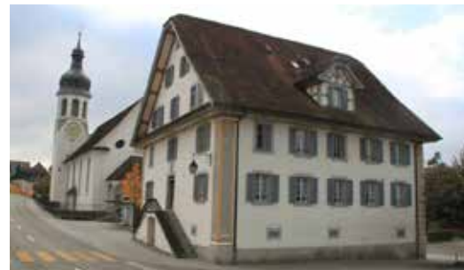
Orthogonal zum Strassenraum stehende Firste engen den Strassenraum ein und wirken mächtig
