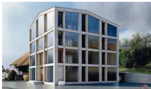
Neubau eines öffentlichen Gebäudes mit Beton-Glasfassade, in der Struktur an einen Riegelbau erinnernd, hebt sich repräsentativ von den umliegenden Bauten ab
