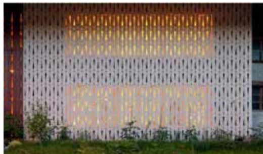
Beispiele modernisierter Mehrzweckbauten ohne Verlust des Charakters im Bereich von Tenn, Stall und Remise
