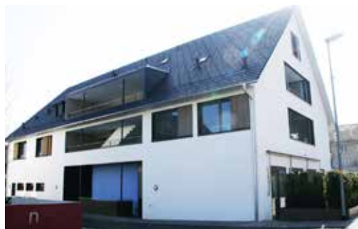
Neubau mit einfachem Volumen und typologisch gestalteten Elementen
